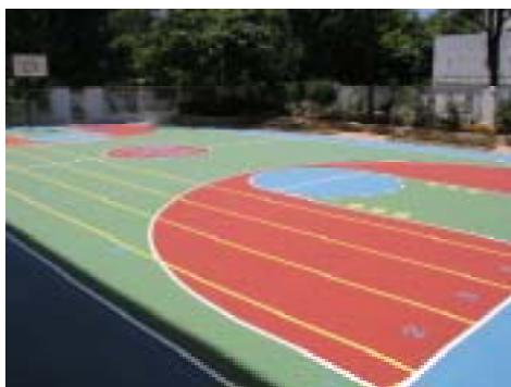
球場重鋪工程
