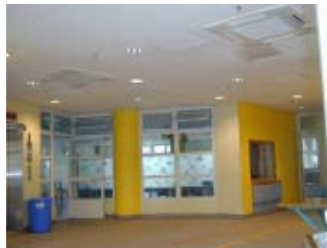
安裝宿舍大堂冷氣
