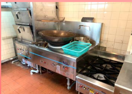
改善宿舍設施，更換廚房爐具
